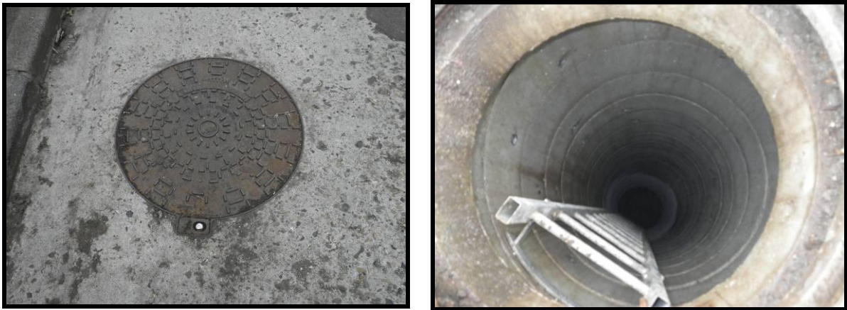
Photographies 2 : Vues du puits d'accès PA1 à la carrière du Chemin Vert
